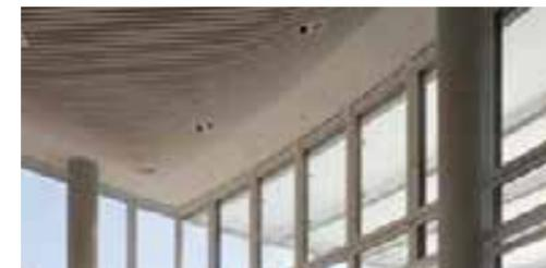
einer Schichtstärke von 14 mm aufgebracht wurden. Abschließend wurde die gesamte Fläche mehrfach feingeschliffen. Im Ergebnis entstanden hochwertige, homogene Flächen in kürzester Bauzeit.
